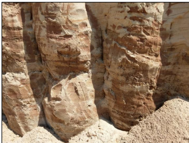
Ryc. 3. Pionowa bariera hydroizolacyjna.
