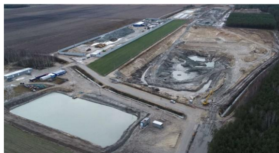
Ryc. 4. System odwadniania powierzchniowego i pierwsze partie urobku glaukonitu z bursztynem.
