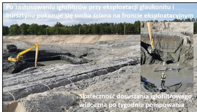
Ryc. 6. Uformowanie się suchego frontu eksploatacyjnego poziomu glaukonitowego.
