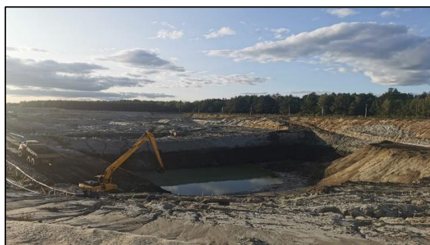
Ryc. 8. Eksploatacja metodą na sucho trzema poziomami: piaskowym; mieszanym i glaukonitowym.
