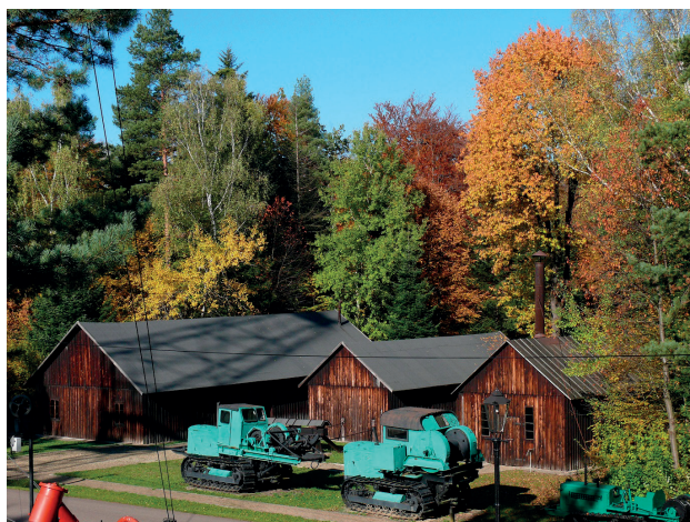
Fig. 1. Drewniane budynki kieratów i kotłowni z XIX w., ze zbiorów Fundacji Bóbrka
